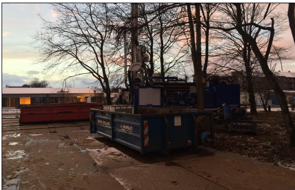
Figur 3. Opstilling af borerig med tilhørende container.
