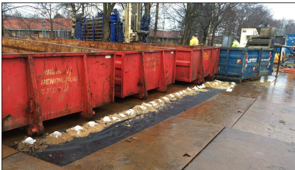
Figur 4. Containere til opbevaring samt oplæg af prøvemateriale til geologisk beskrivelse.
