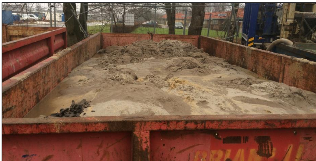
Figur 6. Opboret materiale blev opbevaret i containere på pladsen. Der blev udtaget prøver til analyse inden bortskaffelse.
