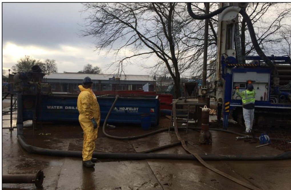
Figur 5. Boringerne blev udført som lufthæve boringer, hvor cirkulerende boremudder transporterer materiale til overfladen, hvor det afsættes i containeren.
