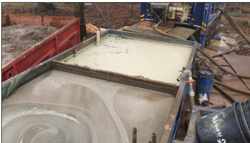
Figur 7. Boremudder og oppumpet vand blev opbevaret i containere på pladsen. Der blev udtaget prøver til analyse inden bortskaffelse.
